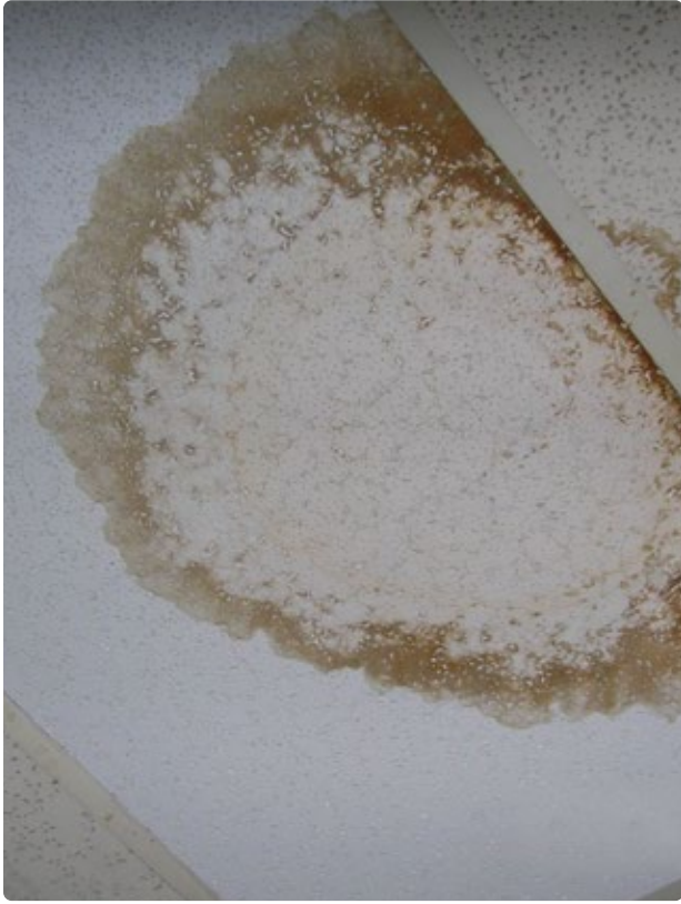
MANCHAS POR GOTERAS, SE PUEDEN CUBRIR CON ÓLEO OPACO.
