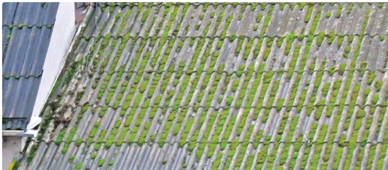
TECHO DAÑADO POR VEJEZ, NO PINTABLE.
