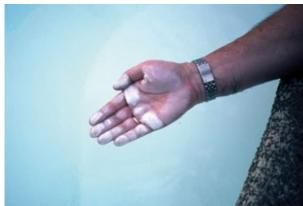
TÉRMINO DE LA PINTURA DE PISCINA POR VEJEZ NATURAL, DEBIDO A OXIDACIÓN PROVOCADA POR EL CLORO
