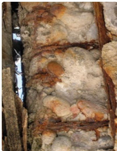
ESTUCOS DELGADOS, DAÑADOS POR ÁCIDO MURIÁTICO.
