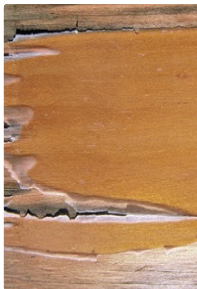
BARNIZ DAÑADO POR FOTODEGRADACIÓN.
