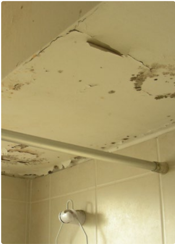
CIELO DE BAÑO DAÑADO POR HONGOS
