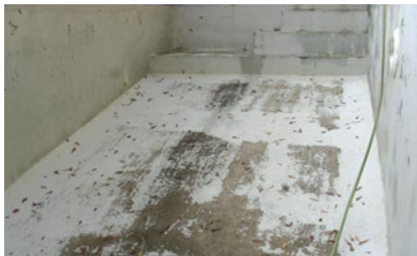
ESTUCO DAÑADO POR ÁCIDO MURIÁTICO
