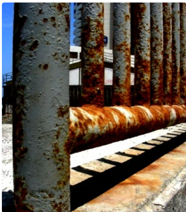
CORROSIÓN CERCANA AL MAR, IQUIQUE, PROVOCADA POR UNA ATMÓSFERA NÍTRICA DE LAS GUANERAS.
