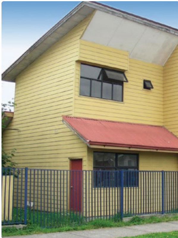
ESMALTE AL AGUA SOBRE SIDING.
