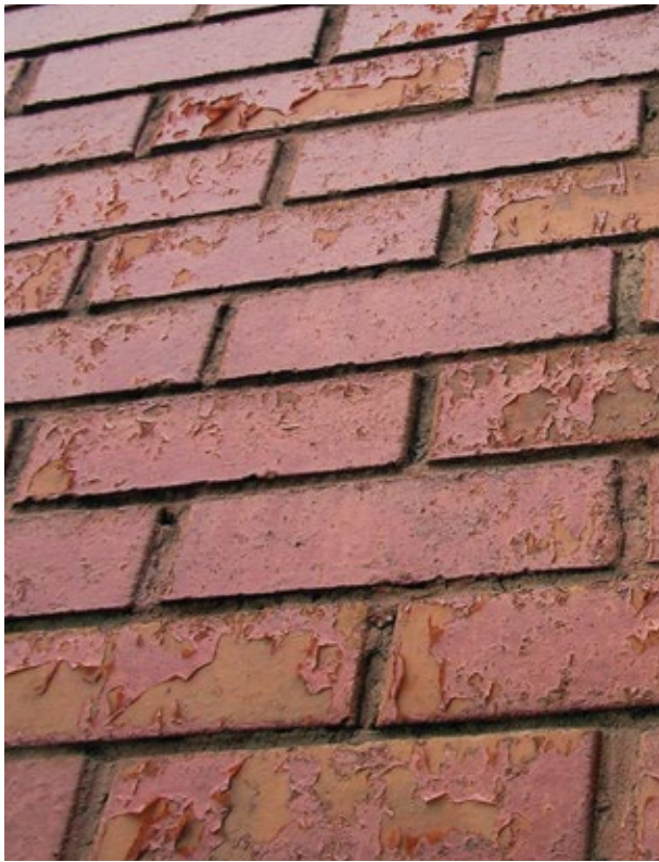
BARNIZ MARINO DESPRENDIDO POR SAPONIFICACIÓN.
