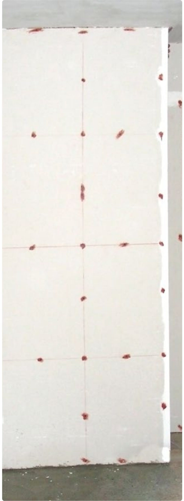
PLANCHA DE YESO - CARTÓN CON PAPEL PINTABLE, CLAVOS INADECUADOS, DEBIENDO SER GALVANIZADO.
