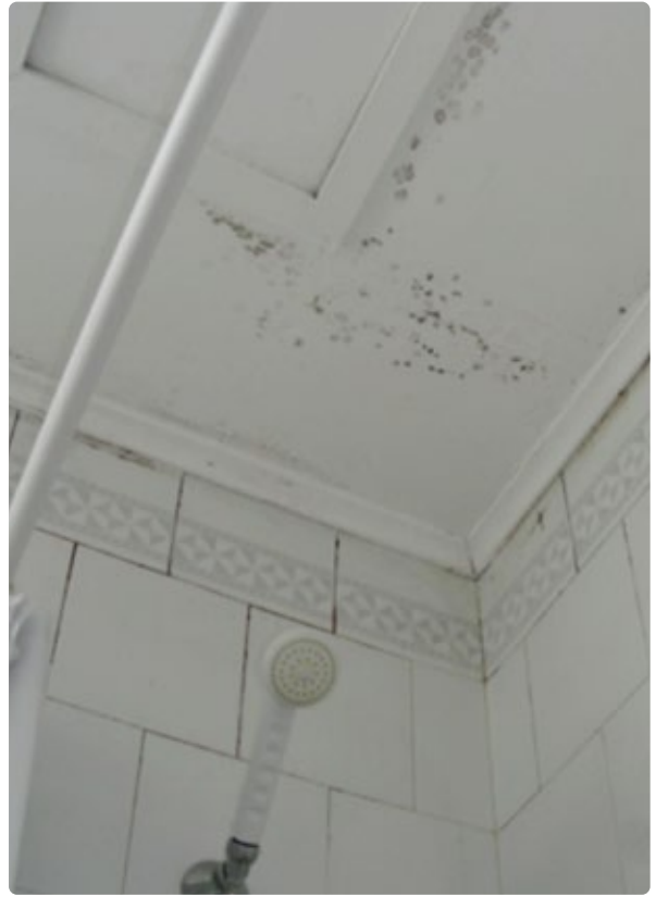
CIELO NO VENTILADO DAÑADO POR HONGOS
