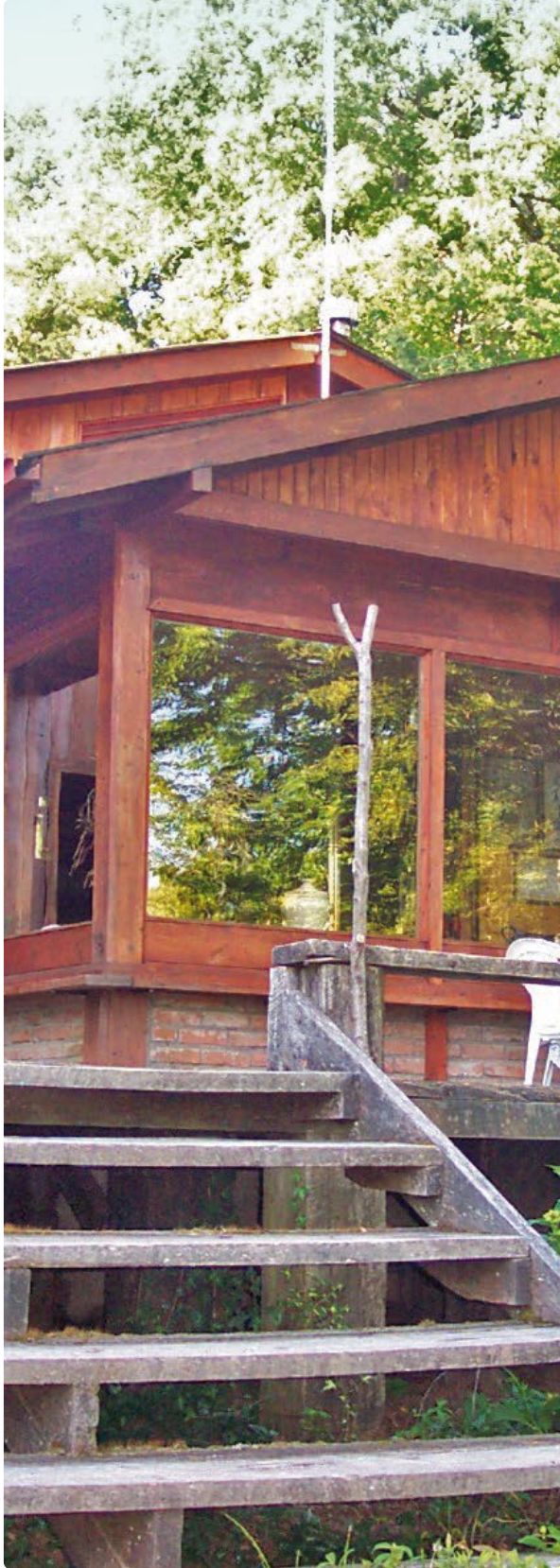
CASA EN CHAPALES (CHILLÁN) IMPREGNADA CON CERESTAIN DE CERESITA.
