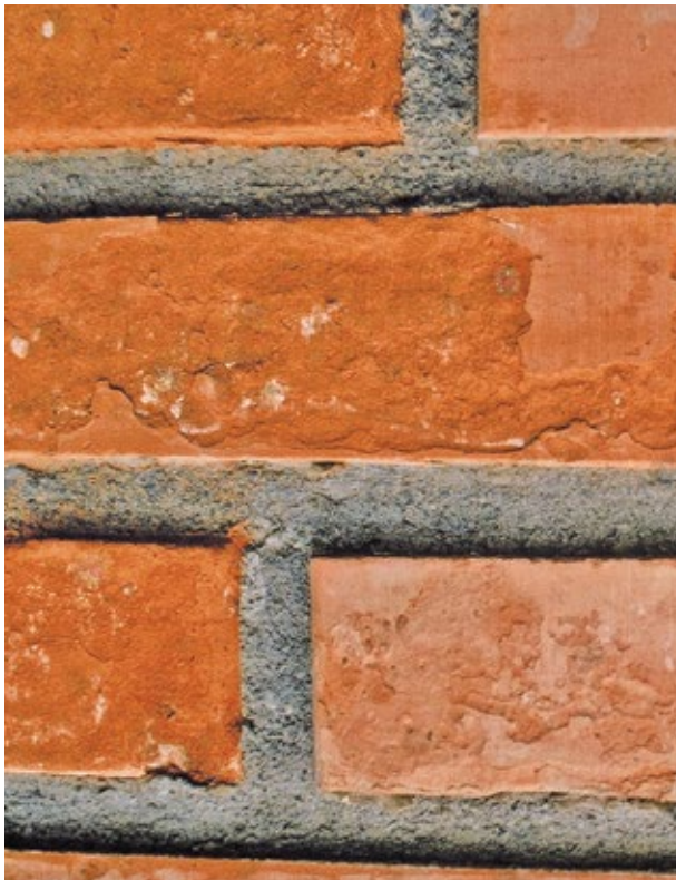
LADRILLOS DAÑADOS POR HUMEDAD Y HELADAS, POR NO HABER SIDO PROTEGIDOS CON SILICONA HIDROFUGANTE.
