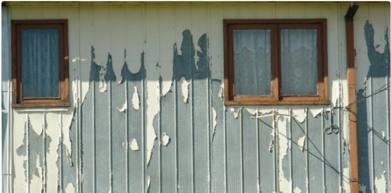
ÓLEO SINTÉTICO DESPRENDIDO POR FALTA DE ADHERENCIA.
