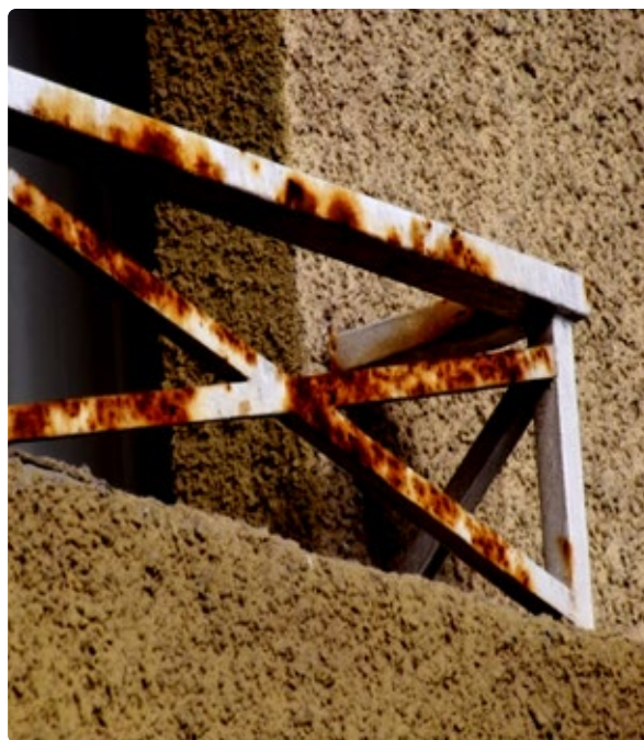
CORROSIÓN POR NIEBLA SALINA, AV. DEL MAR, LA SERENA.
