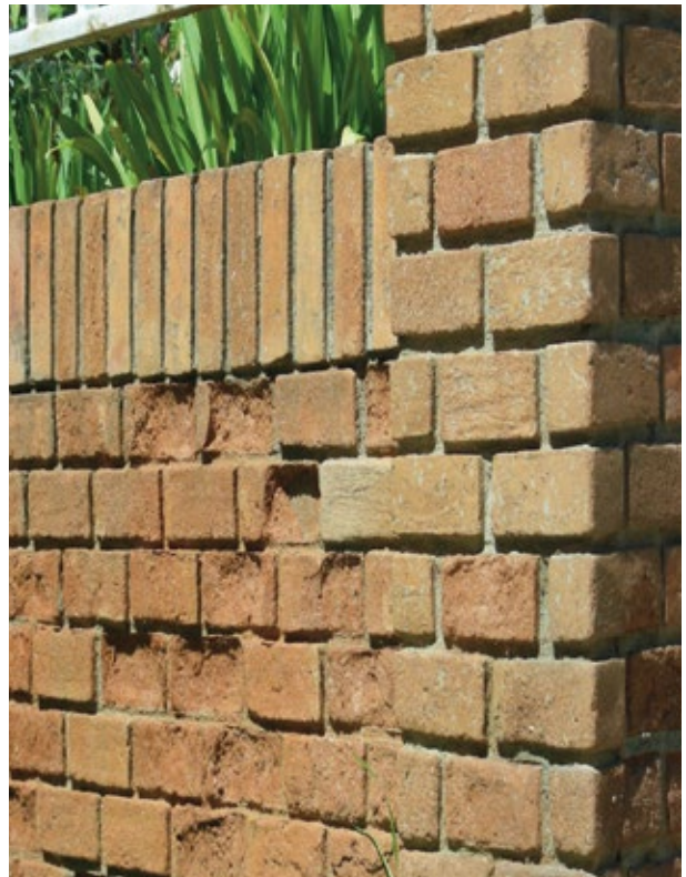
LADRILLOS SIN PROTECCIÓN DAÑADOS POR HUMEDAD Y RIEGO.
