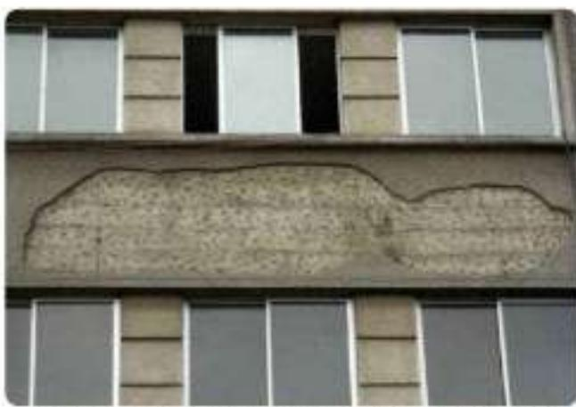
*Estuco desprendido por resto de desmoldantes en el hormigón*
