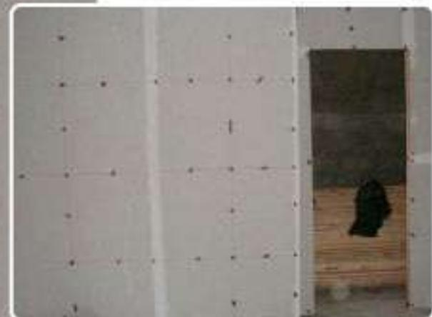
Fijaciones inadecuadas que tuvieron que recubrirse con pintura anticorrosiva para evitar la corrosión
